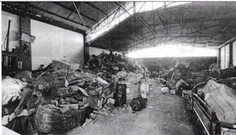
Imagen 4. Muros y cubierta
