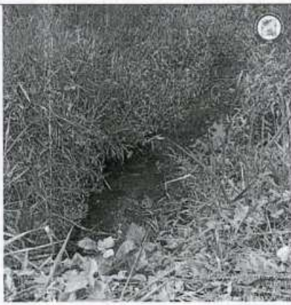
Fotografía 23 y 24. Afloramiento de lixiviados y drenaje al costado sur de la celda tres (3) del relleno sanitario La Florida.
