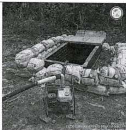
Fotografía 5 y 6. Pozo séptico y sistema de aperción para el manejo de lixiviados.
