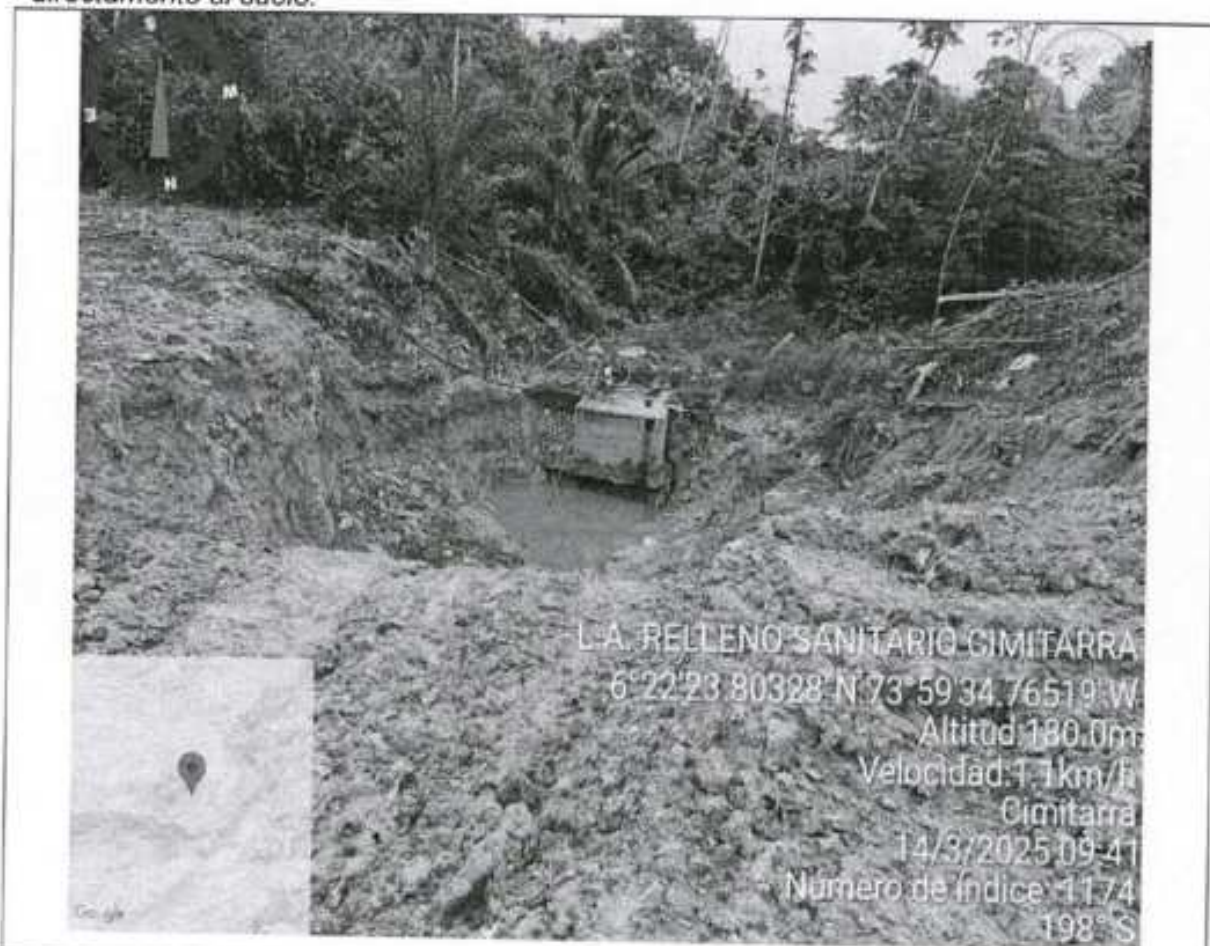
Fotografía 13. Trabajos en el área del "pozo séptico"
