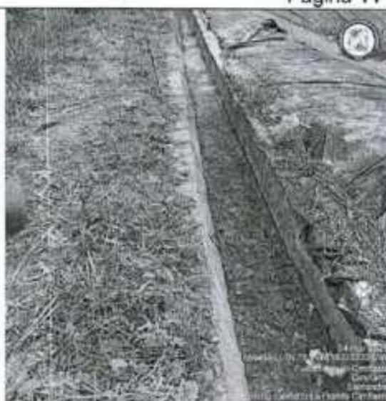
Fotografía 8. Canal perimetral para la celda
