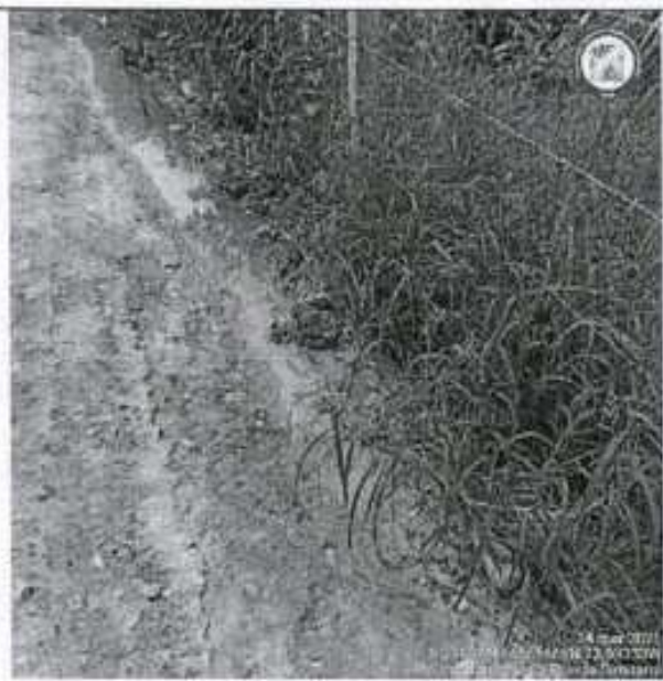
Fotografía 23 y 24. Afloramiento de lixiviados y drenaje al costado sur de la celda tres (3) del relleno sanitario La Florida.
