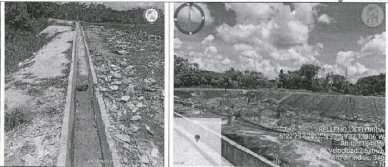
Fotografía 1 y 2. Canal perimetral para la celda 4 del relleno sanitario La Florida.
