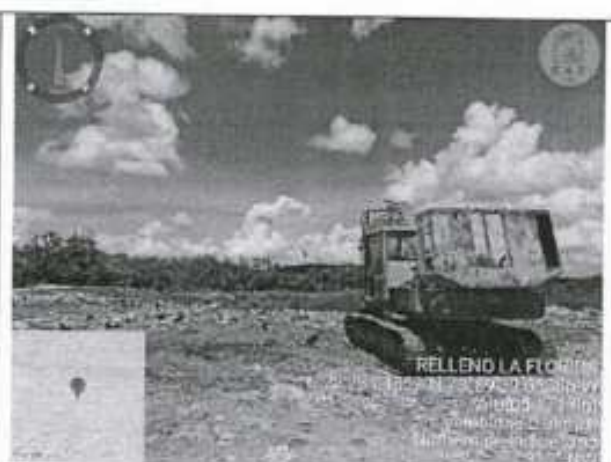
Fotografía 4. Maquinaria utilizada para la compactación de residuos de la celda 4.
