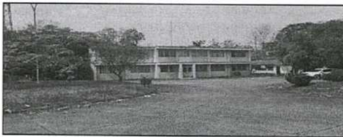
Fotografía No. 1. Edificio administrativo – fuera de servicio Fuente: CAS 2024
