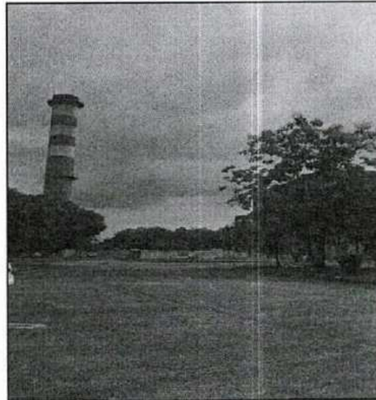
Fotografía No. 11. Visitar Termo barranca – cierre y abandono Fuente: CAS 2024
